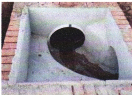
Figura 01: Fundo e corte das caixas de inspeção.
