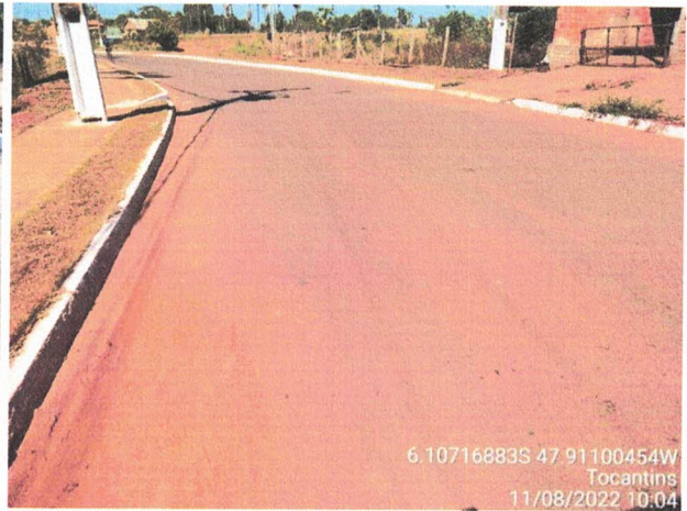
Foto 18: Vista geral do pavimento da Av. Palmeiras.
