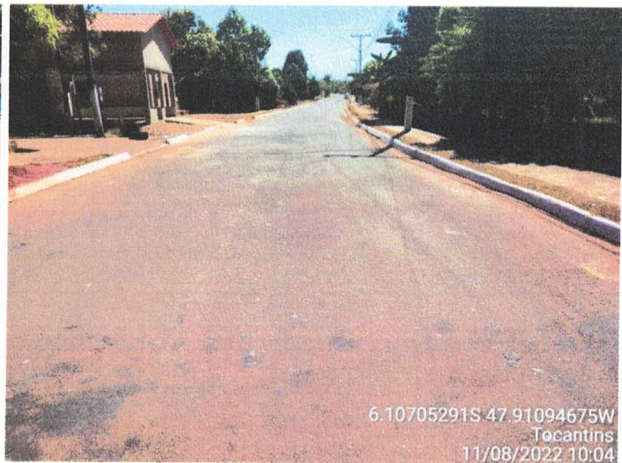
Foto 20: Vista geral do pavimento da Av. Palmeiras.
