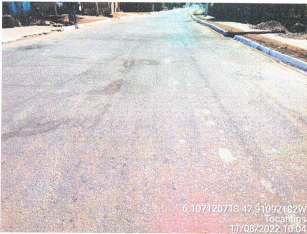
Foto 17: Vista geral do pavimento da Av. Palmeiras.
