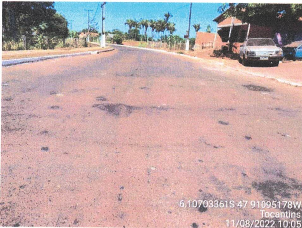
Foto 19: Vista geral do pavimento da Av. Palmeiras.
