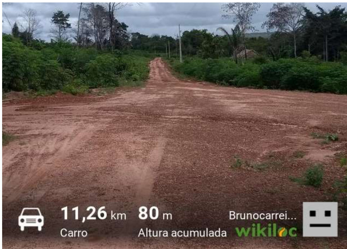
Foto 03: Região Aldeinha - Final do Trecho 02 Coordenadas: Latitude: -6.099724; Longitude: -47.832531
