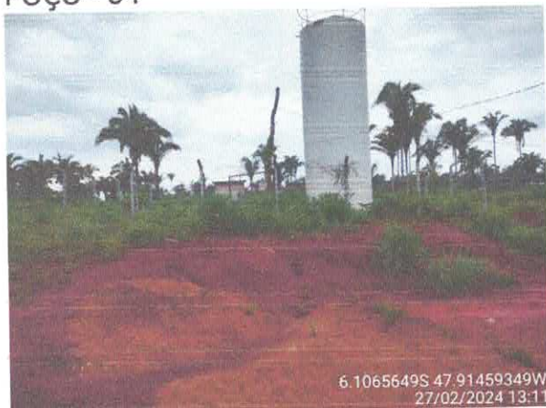
Foto 52: Fechamento existente, instalar portão novo.
