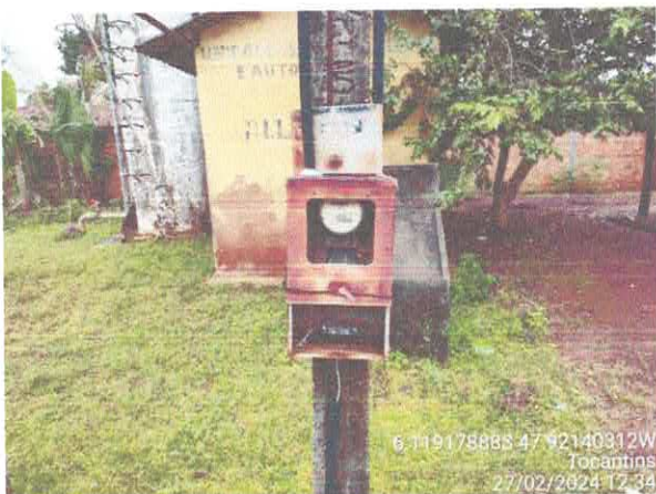
Foto 17: Substituir padrão existente.
