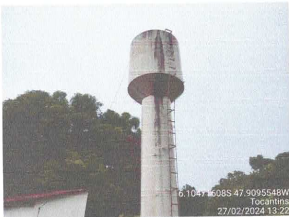
Foto 74: Recuper. de Reservatório e Reparos Tubulação.
