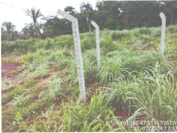
Foto 56: Fechamento existente, instalar portão novo.
