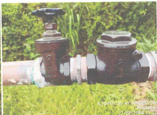
Foto 77: Reparos da Tubulação e Registro danificados.
