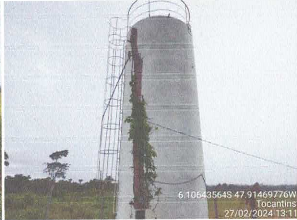
Foto 59: Reservatório novo, sem necessidade de reparos.
