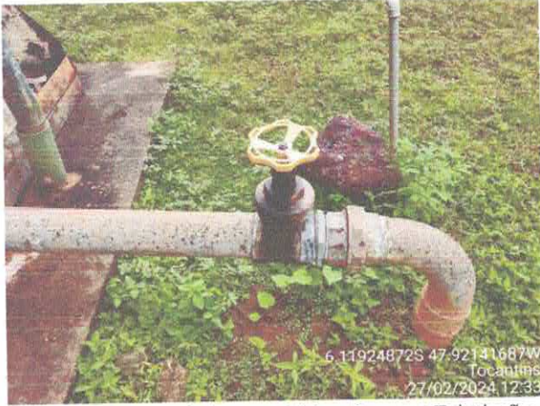
Foto 13: Recuper. de Reservatório e Reparos Tubulação.
