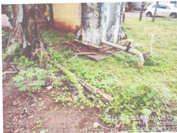
Foto 09: Recuper. de Reservatório e Reparos Tubulação.
