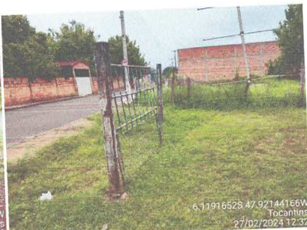
Foto 04: Local do Poço 01, fazer fechamento, depósito. Recuperação de Reservatório e Tubulação.
