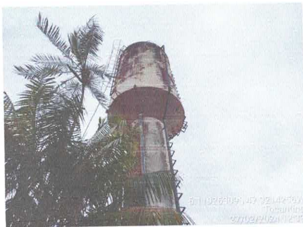
Foto 11: Recuper. de Reservatório e Reparos Tubulação.
