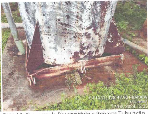
Foto 14: Recuper. de Reservatório e Reparos Tubulação.
