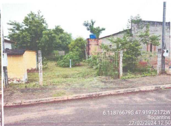
Foto 19: Fechamento da área com mourão de concreto.
