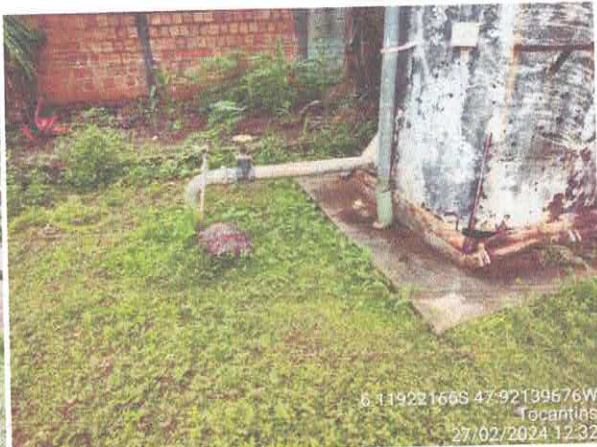
Foto 06: Recuper. de Reservatório e Reparos Tubulação.
