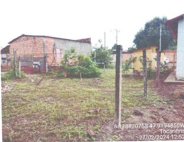
Foto 30: Fechamento da área com mourão de concreto.
