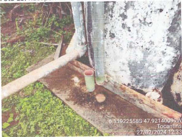
Foto 15: Recuper. de Reservatório e Reparos Tubulação.
