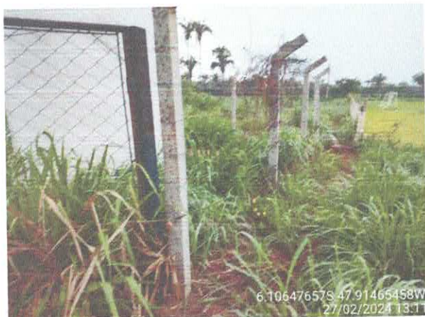
Foto 54: Fechamento existente, instalar portão novo.
