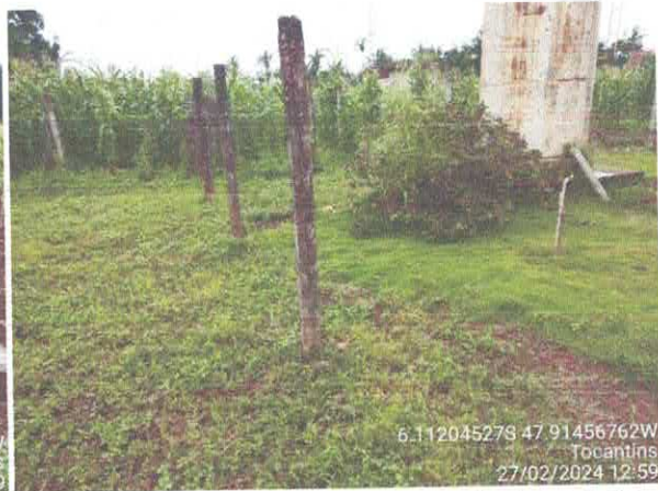
Foto 34: Fechamento da área com mourão de concreto. Foto 35: Fechamento da área com mourão de concreto.
