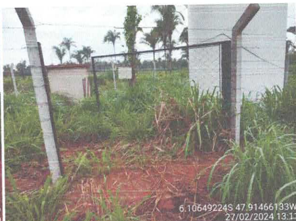
Foto 53: Fechamento existente, instalar portão novo.
