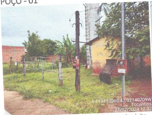
Foto 01: Local do Poço 01, fazer fechamento, depósito. Recuperação de Reservatório e Tubulação.
