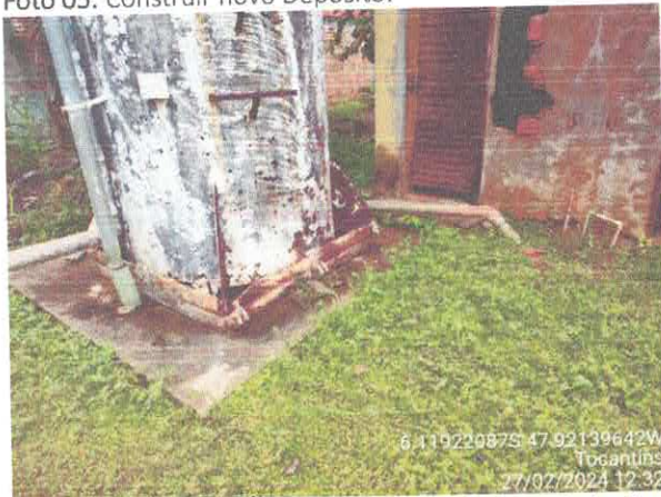
Foto 07: Recuper. de Reservatório e Reparos Tubulação.
