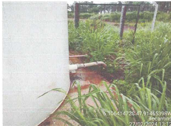
Foto 62: Reservatório novo, sem necessidade de reparos
