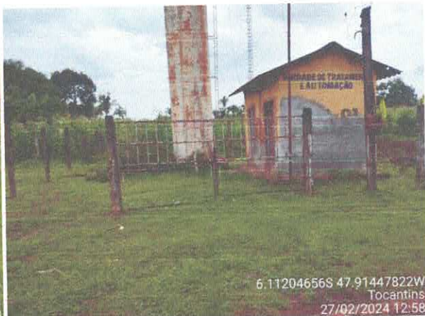
Foto 51: Substituir padrão existente.
