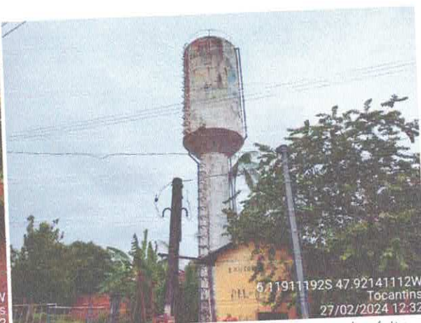
Foto 02: Local do Poço 01, fazer fechamento, depósito. Recuperação de Reservatório e Tubulação.
