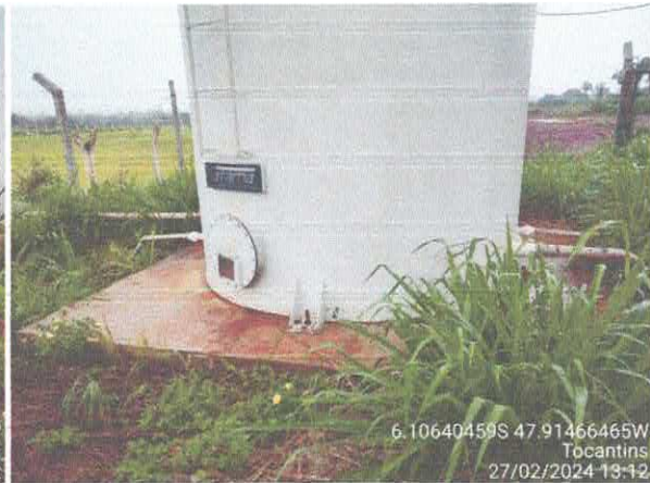
Foto 61: Reservatório novo, sem necessidade de reparos.
