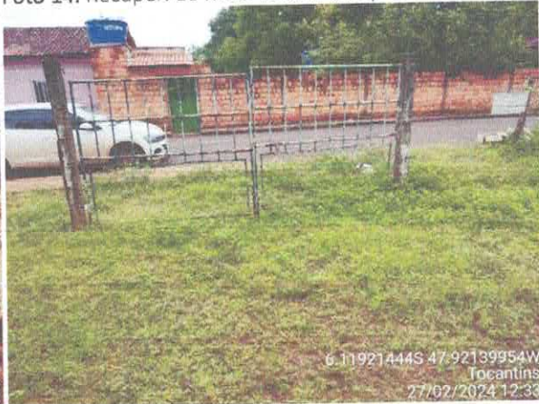
Foto 16: Fechamento da área com mourão de concreto.
