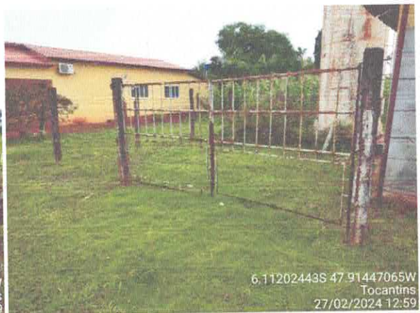
Foto 33: Fechamento da área com mourão de concreto.
