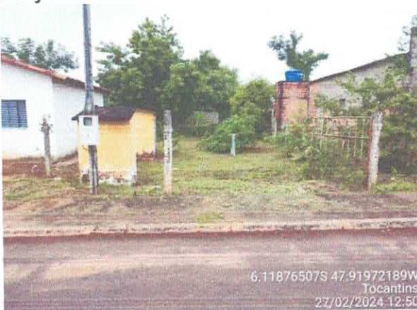
Foto 18: Fechamento da área com mourão de concreto.
