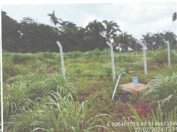
Foto 55: Fechamento existente, instalar portão novo.
