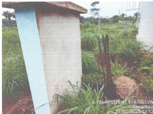
Foto 60: Reservatório novo, sem necessidade de reparos
