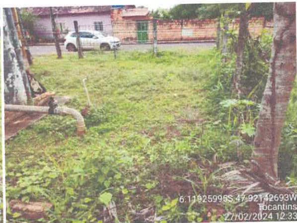
Foto 10: Fechamento da área com mourão de concreto.
