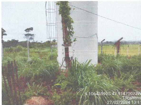
Foto 58: Reservatório novo, sem necessidade de reparos
