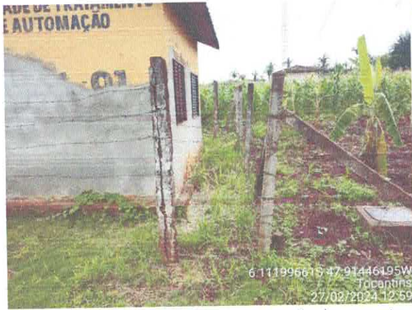
Foto 34: Fechamento da área com mourão de concreto. Foto 35: Fechamento da área com mourão de concreto.
