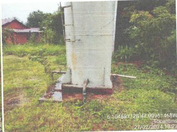
Foto 79: Recuper. de Reservatório e Reparos Tubulação.
