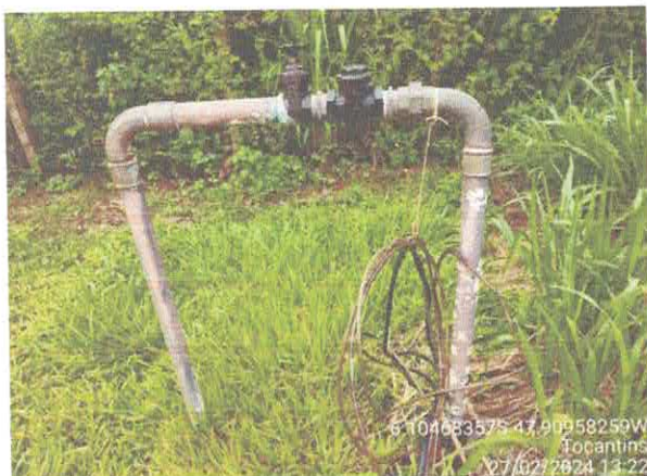
Foto 76: Reparos da Tubulação e Registro danificados.
