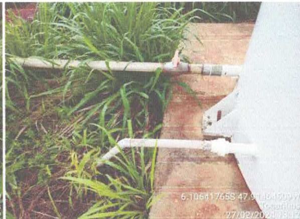
Foto 63: Reservatório novo, sem necessidade de reparos.
