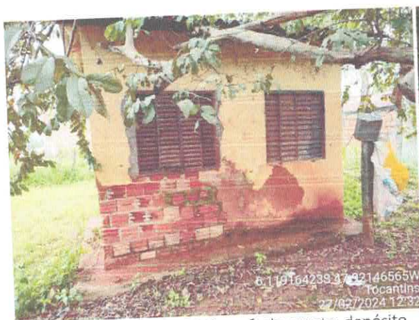
Foto 03: Local do Poço 01, fazer fechamento, depósito. Recuperação de Reservatório e Tubulação.
