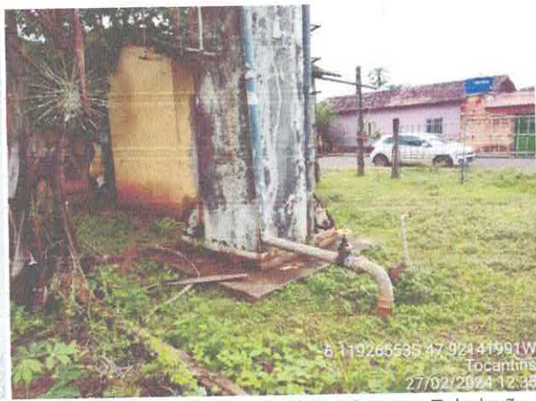
Foto 12: Recuper. de Reservatório e Reparos Tubulação.
