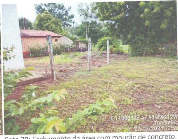
Foto 29: Fechamento da área com mourão de concreto.
