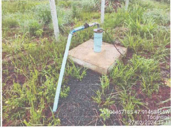
Foto 57: Fechamento existente, instalar portão novo.
