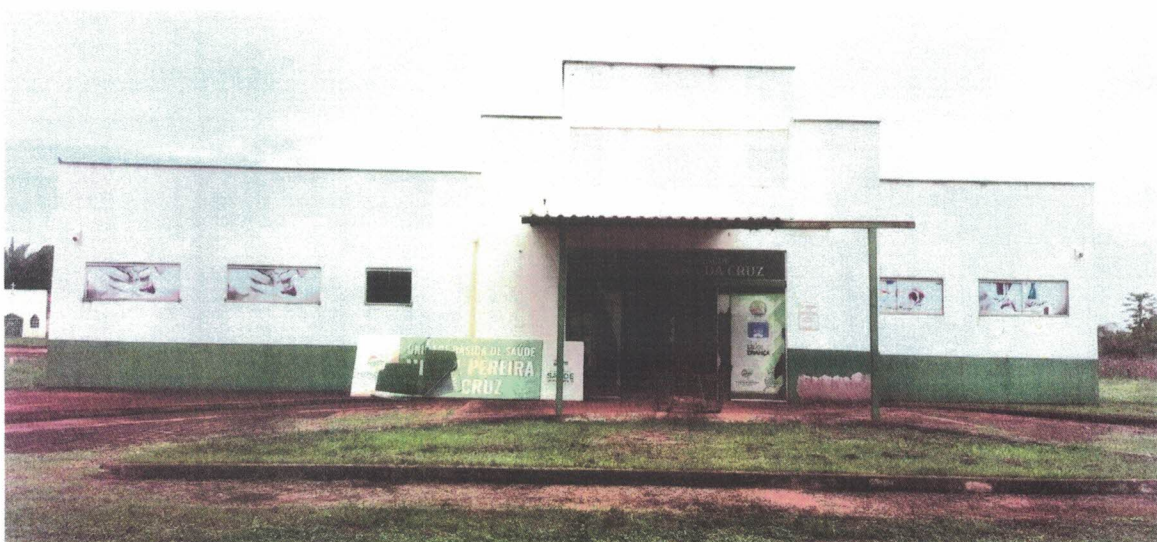
Foto 01: Vista Frontal do Prédio.
