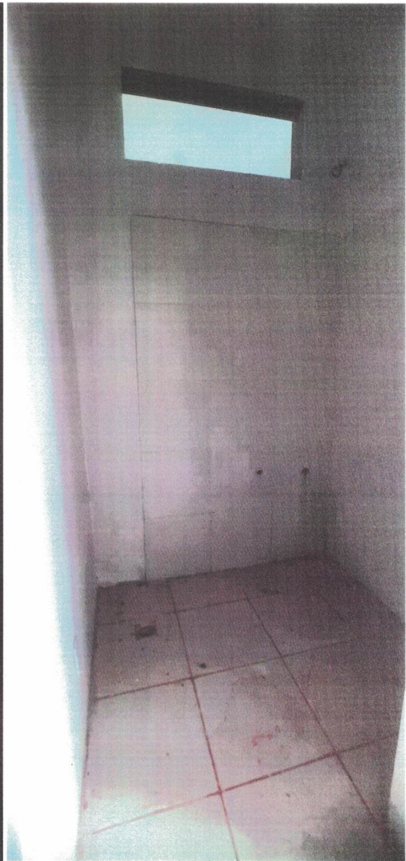
Foto 12: Vista interna do Prédio - DML.
