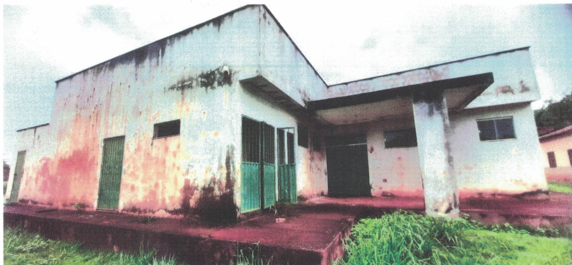
Foto 03: Vista Fundo do Prédio.
