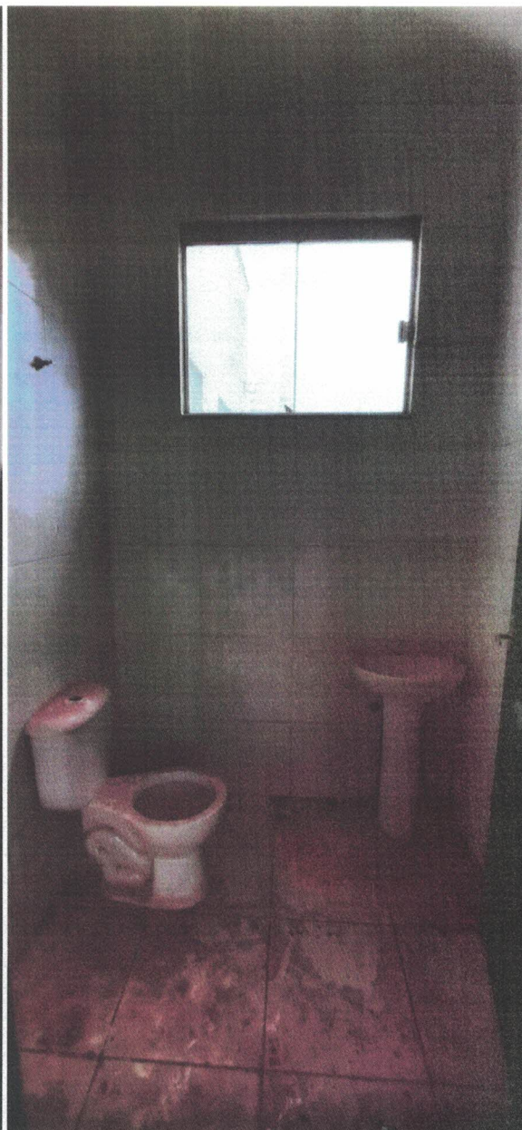
Foto 10: Vista interna do Prédio - Banheiro.
