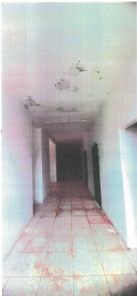
Foto 07: Vista interna do Prédio - Circulação.
