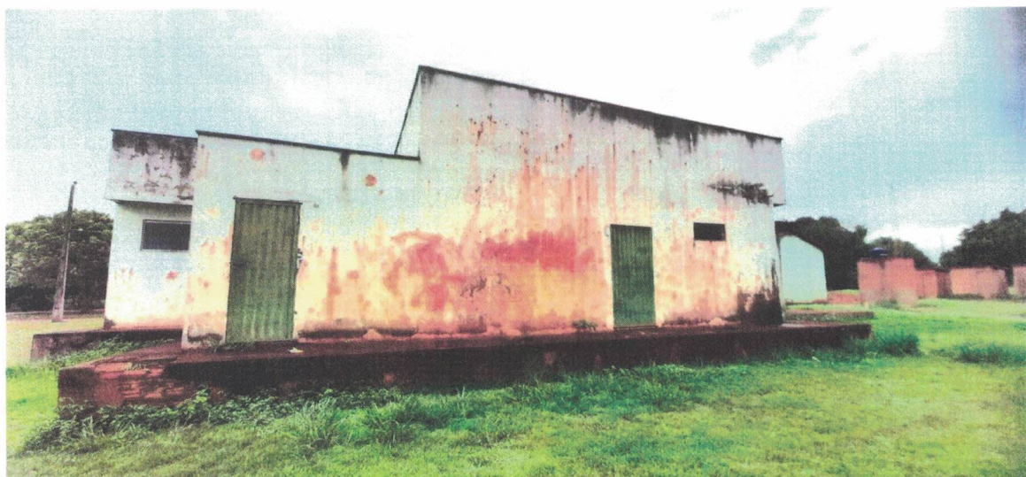
Foto 04: Vista Fundo do Prédio.
