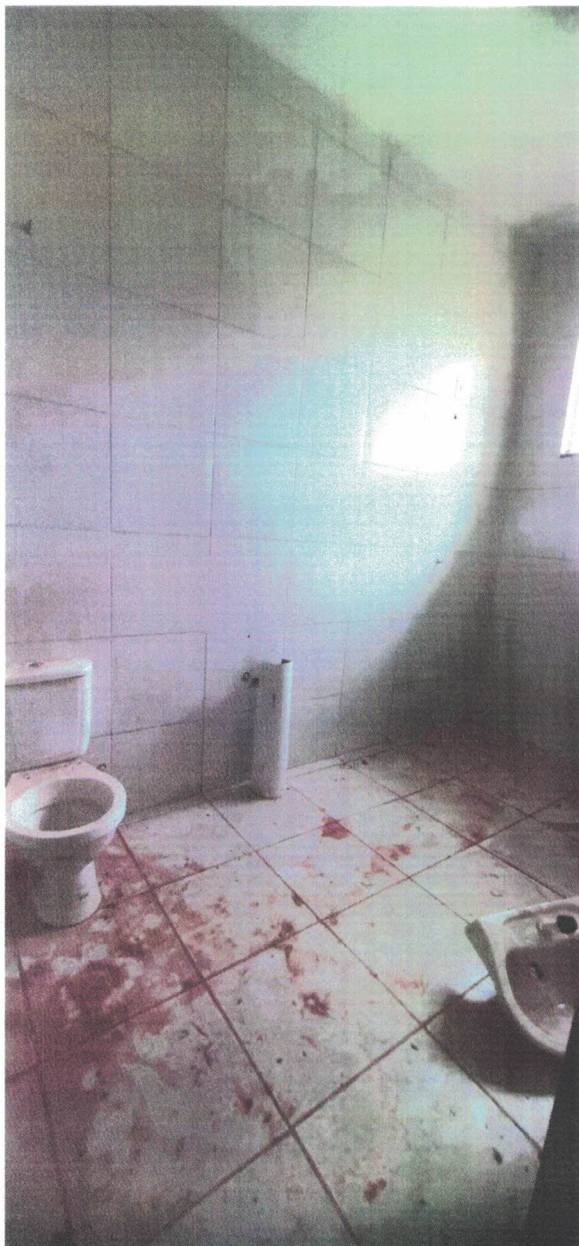
Foto 19: Vista interna do Prédio - Banheiro.
