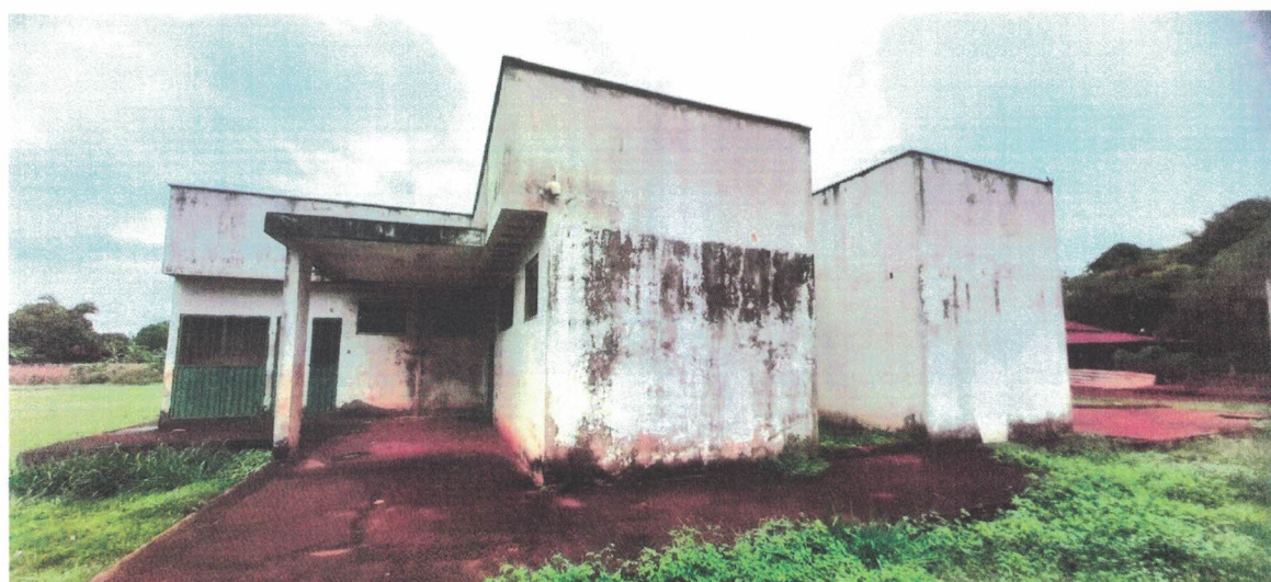
Foto 05: Vista Lateral Esquerda do Prédio.
