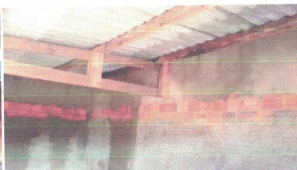
Foto 30: Infiltração na parte inferior do telhado.
