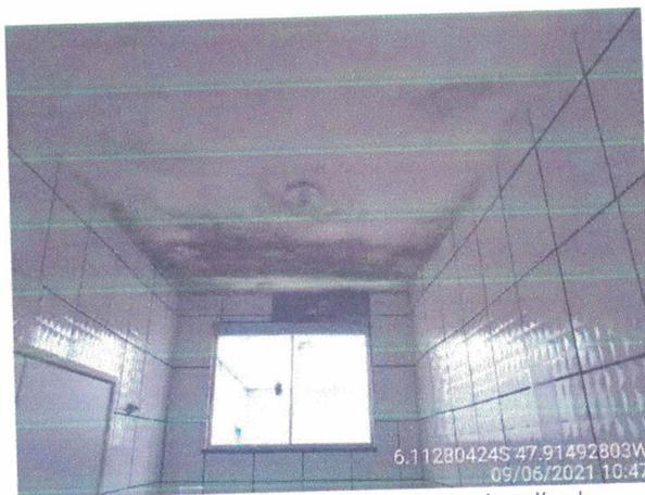
Foto 21: Infiltração em laje, proveniente do telhado.
