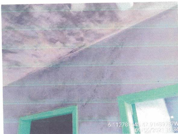
Foto 11: Infiltração em laje, proveniente do telhado.
