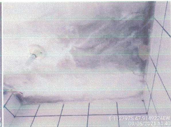
Foto 16: Infiltração em laje, proveniente do telhado.
