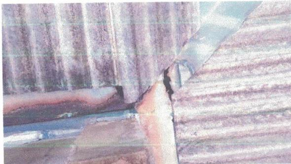
Foto 27: Calha danificada com rasgos, peça solta.
