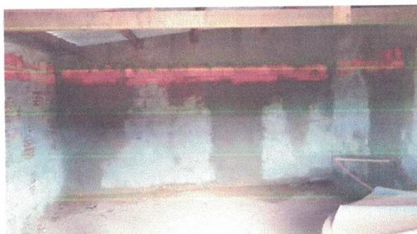
Foto 31: Infiltração na parte inferior do telhado.
