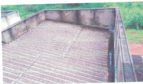
Foto 25: Calha danificada, com empoçamento.
