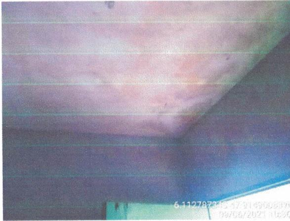
Foto 13: Infiltração em laje, proveniente do telhado.
