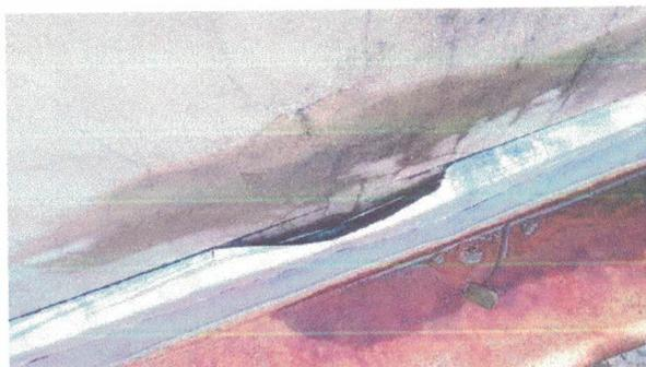
Foto 29: Calha danificada com rasgos, peça solta.
