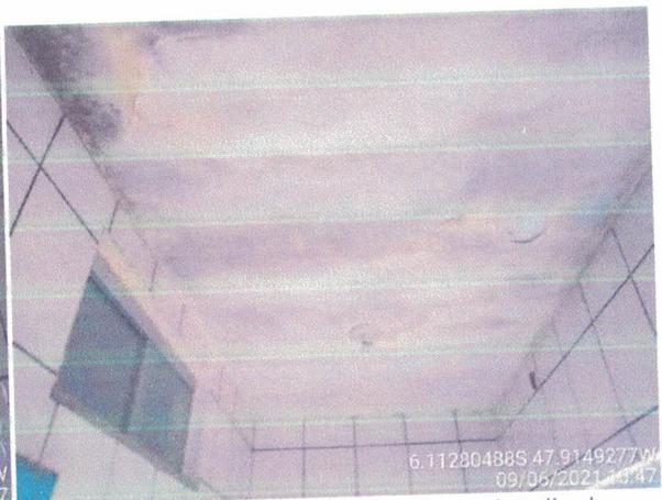
Foto 22: Infiltração em laje, proveniente do telhado.
