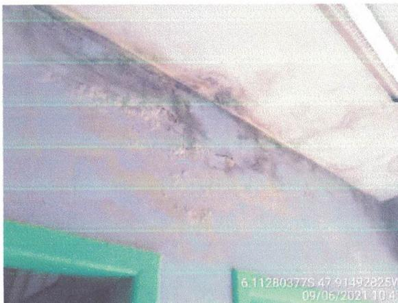
Foto 17: Infiltração em laje, proveniente do telhado.
