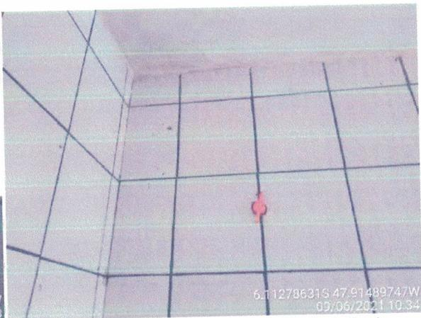
Foto 10: Infiltração em laje, proveniente do telhado.
