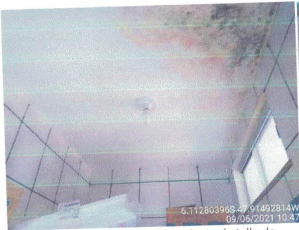
Foto 19: Infiltração em laje, proveniente do telhado.
