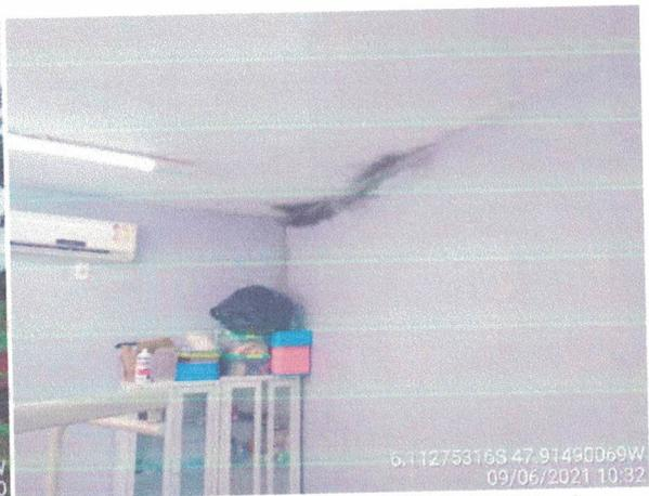
Foto 08: Infiltração em laje, proveniente do telhado.
