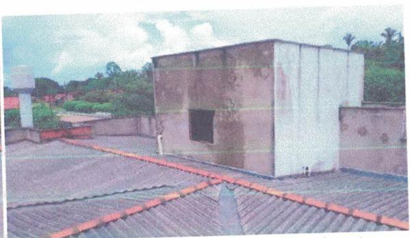
Foto 24: Cobertura existente em telha fibrocimento.
