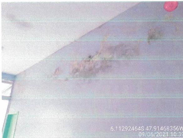
Foto 15: Infiltração em laje, proveniente do telhado.
