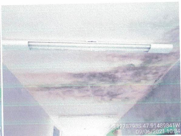
Foto 12: Infiltração em laje, proveniente do telhado.
