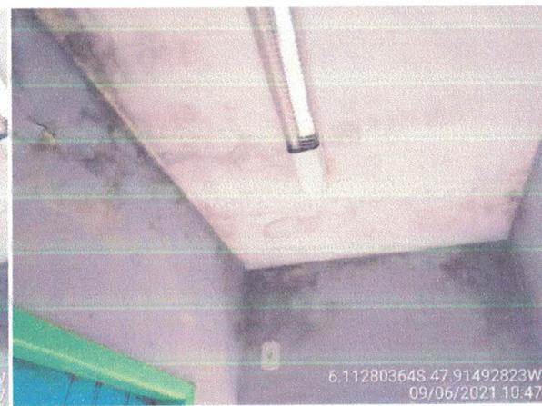
Foto 18: Infiltração em laje, proveniente do telhado.
