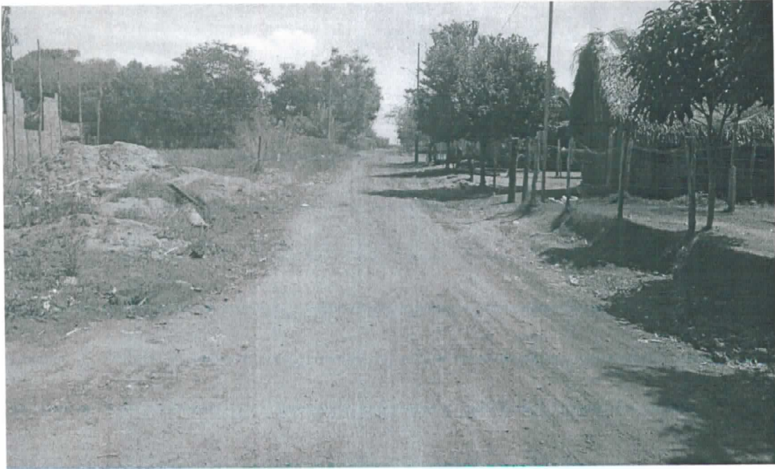
Foto 02: Final da Rua São João Coordenadas: S: 6° 7' 18,76" ; O: 47° 55' 12,49"
