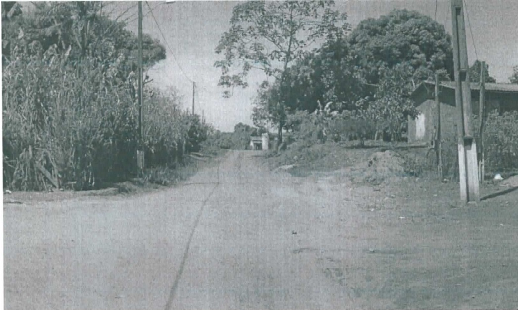
Foto 15: Final da Rua Travessa 15 de Novembro Coordenadas: S: 6° 7' 26,43" ; O: 47° 55' 27,59"
