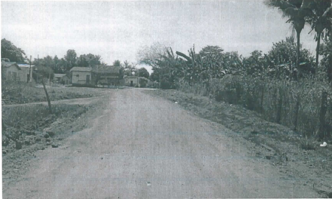
Foto 06: Final da Avenida Cônego João Lima Coordenadas: S: 6° 7' 28,51" ; O: 47° 55' 26,66"
